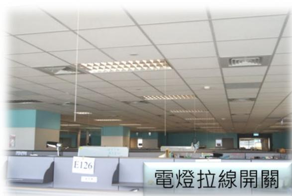
圖 5-20、燈管系統節能-電燈拉線開關
